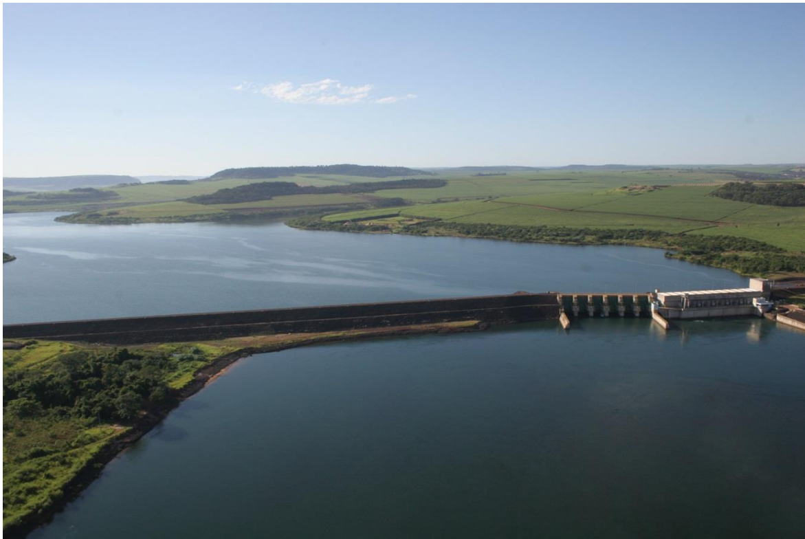
Figura 03 - Vista geral da Barragem da UHE Igarapava
