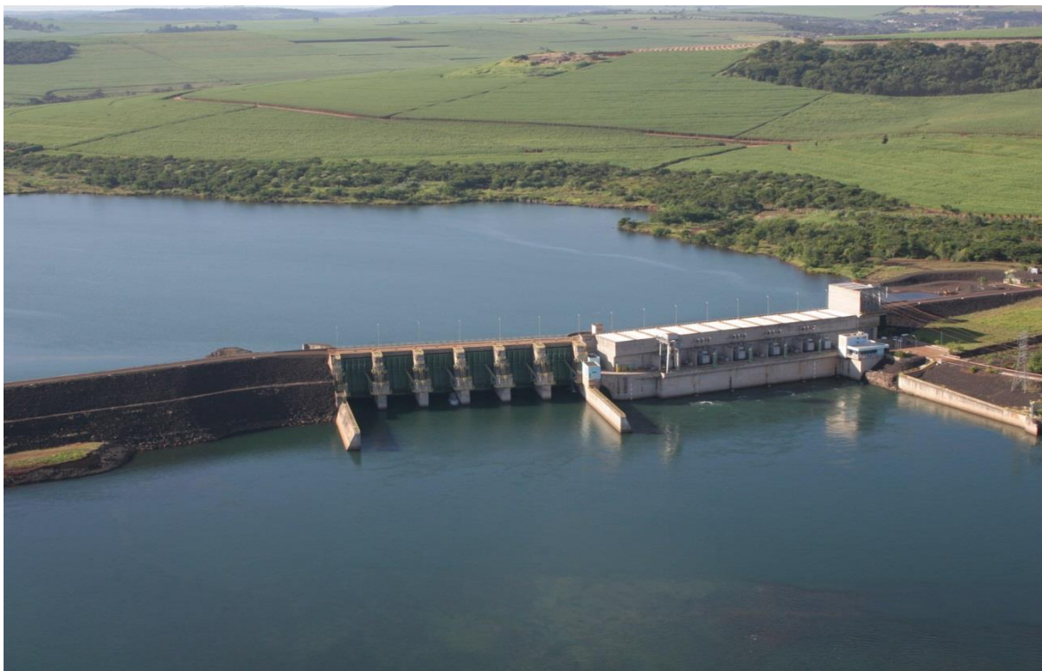
Figura 04- Vertedouro e Casa de Força UHE Igarapava
